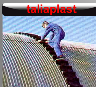
un toit en tôle
